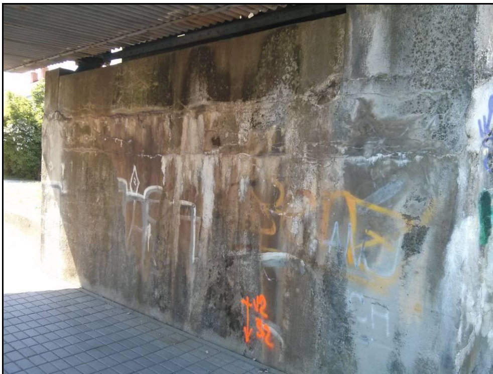
Obr. č. 7 - pohled na opěru Znojmo - průsaky vody skrze cementovou omítku, na povrchu s tvorbou karbonátových sraženin vyloužených z pojiva betonu pod omítkou.
