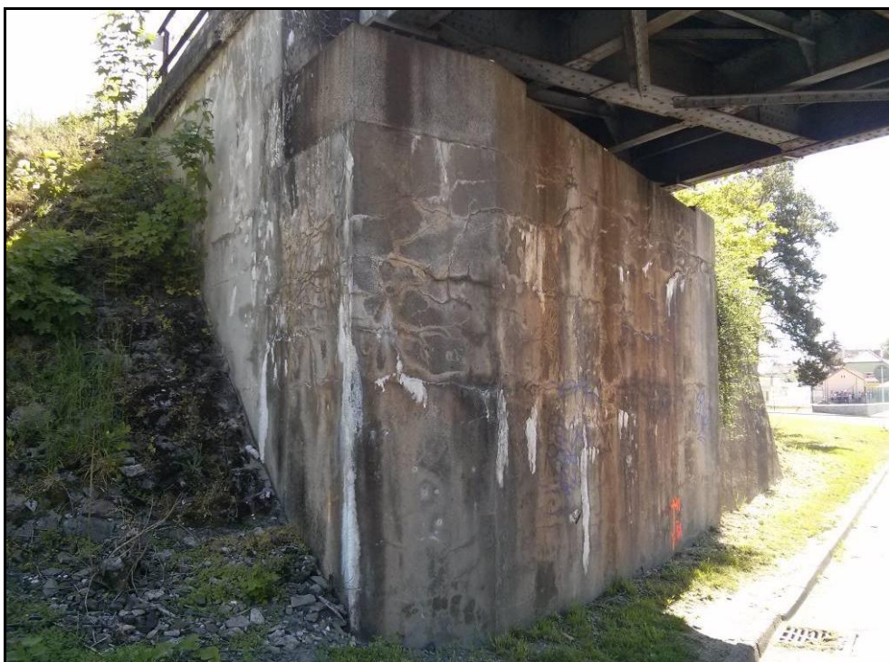
Obr. č. 6 - pohled na opěru Břeclav - průsaky vody skrze cementovou omítku, na povrchu s tvorbou karbonátových sraženin vyloučených z pojiva betonu pod omítkou.
