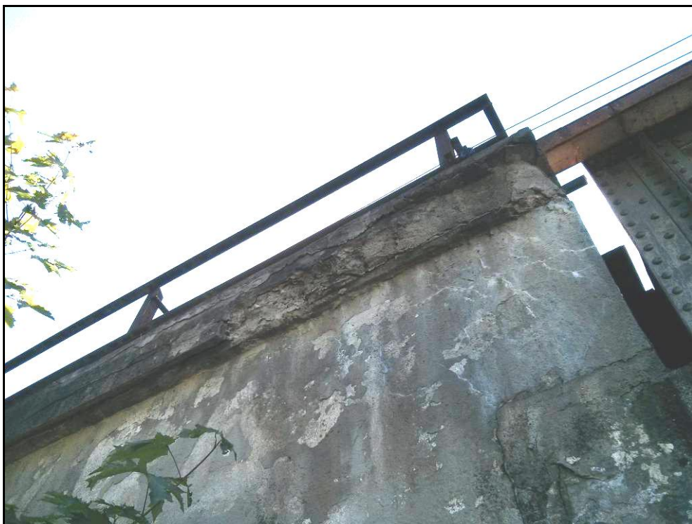
Obr. č. 10 - pohled na silně porušený beton pravé římsy u opěry Břeclav
