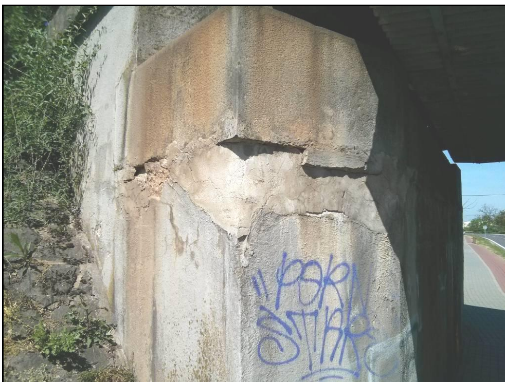
Obr. č. 8 - pohled na vysrávku porušeného betonu na levém nároží opěry Znojmo.
