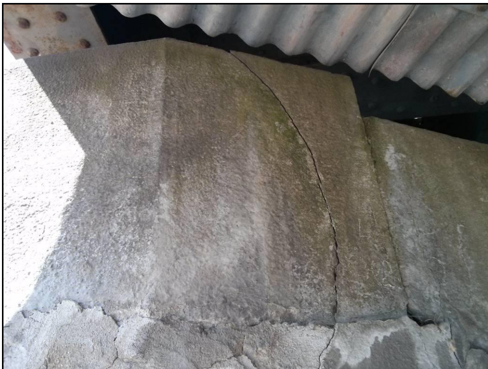
Obr. č. 9 - pohled na trhlinu levého mostního prahu opěry Znojmo
